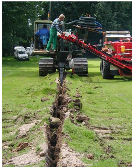
Placement de tuyaux de drainage
